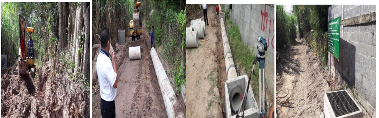
โครงการวางท่อระบายน้ำ
