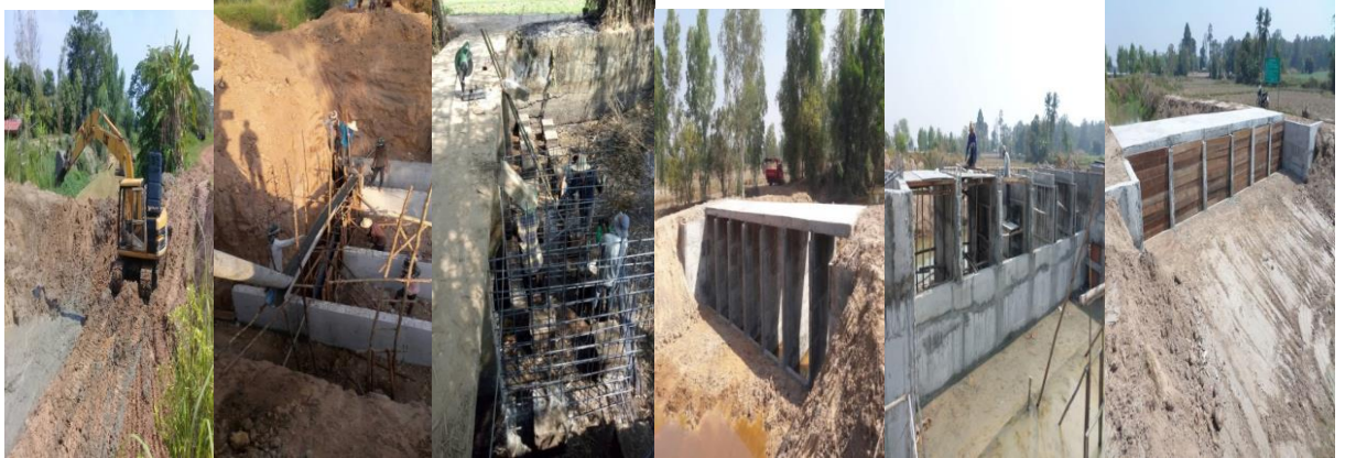
โครงการก่อสร้างฝายน้ำล้นคอนกรีตเสริมเหล็ก
